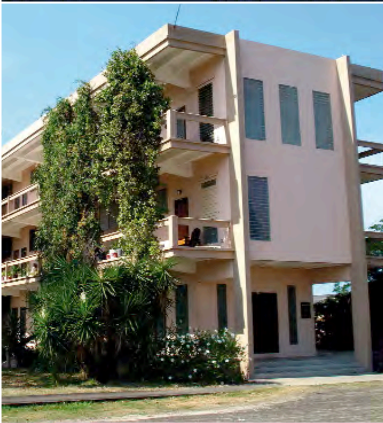
La cappella Fordyce e la Melhado Hall.
